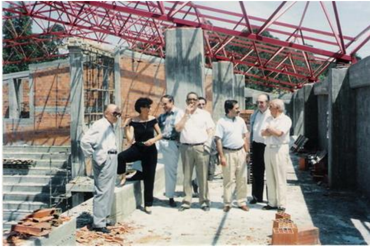
A Comissão em visita às obras do Pavilhão
